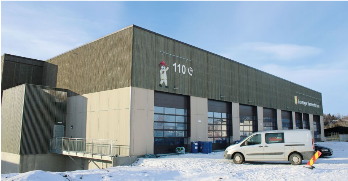
Figur 6 Levanger brannstasjon ( https://byggprosjekter.bygg.no/2024-trondelag/levanger-brannstasjon/2229609 )
